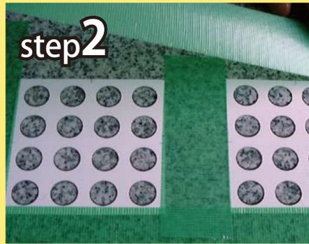
step2 お好みのパターンになるようにマスキングします。このとき専用のパターンシートを使うと手軽に模様が作れます。塗料が付くと困る場所にはマスキングテープなどで養生しておきます。
