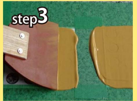
step3 必要に応じて下塗りした後、ゴムヘラ、ハケ、ローラーなどでパターンが完全に隠れるように、塗料を平滑に塗り広げます。厚塗りしすぎると、ひび割れが起きるのでご注意ください。
